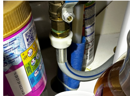
Varerør mangler endetetting
