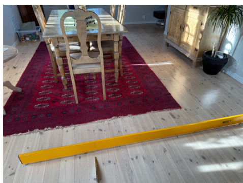
Kontroll av planhet gulv stue
