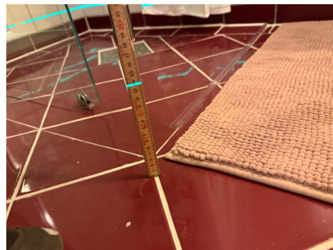
Kontroll av fallforhold bad kjeller med niveringslaser
