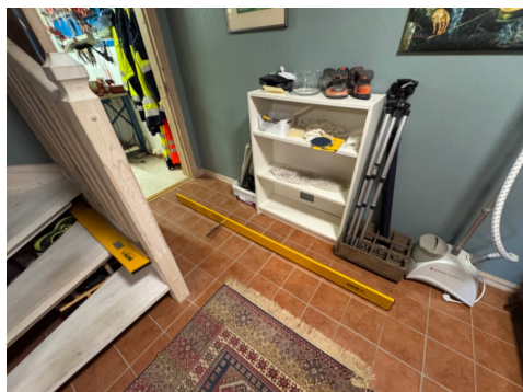
Kontroll av planhet gulv kjeller
