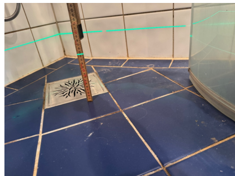
Kontroll av fallforhold med niveleringslaser badegulv
