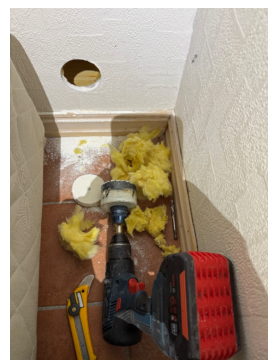
Hulltaking i vegg soverom bak dusj
