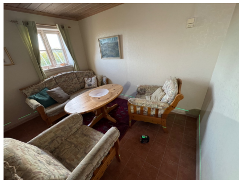
Kontroll av høyder gulv kjeller
