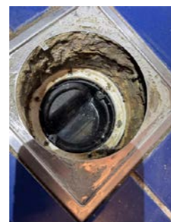
Sluk i dusjen. Banemembran under klemring.
