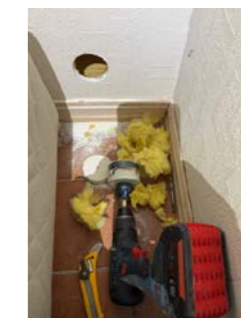
Hulltaking i vegg soverom bak dusj
