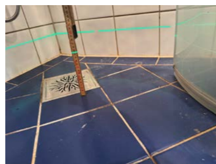
Kontroll av fallforhold med nivåeringslaser badegulv
