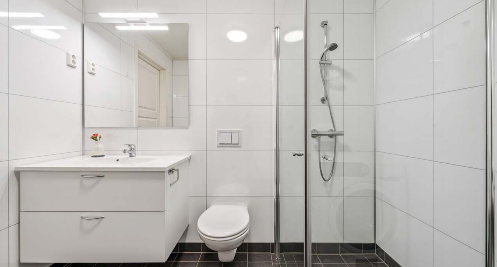
Flislagt baderom med elektriske varmekabler i gulvet.
