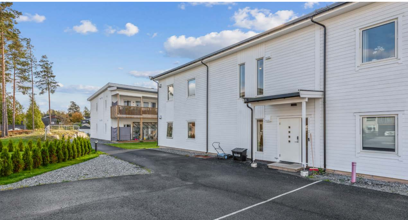
Leilighet har felles inngangsparti, med videre innvendig adkomst til sin leilighet.
