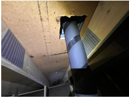
Ikke tettet rundt rør
