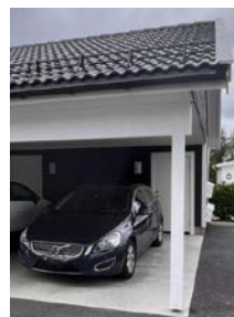
Carport og utvendig bod til denne boligen.
