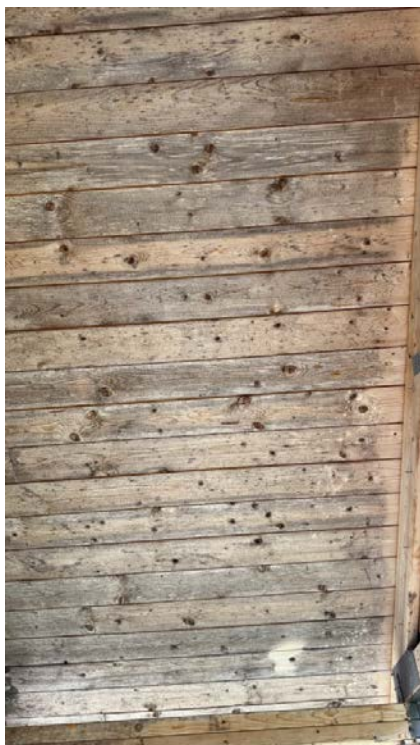
Svertesopp i ubehandlet panel.
