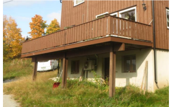
Åpen solterrasse ut for stue og kjøkkengavl. Adkomst fra stue.
