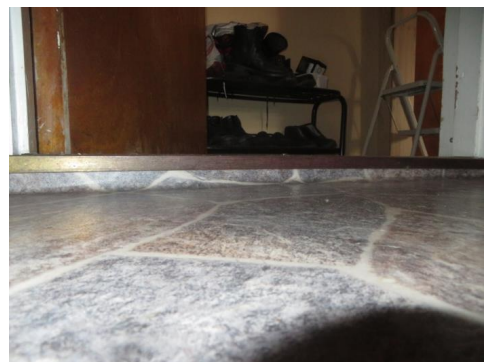
Belegg lagt opp etter terskel som flomsikring.
