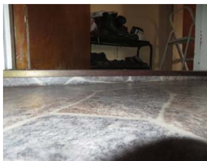
Belegg lagt opp etter terskel som flomsikring.
