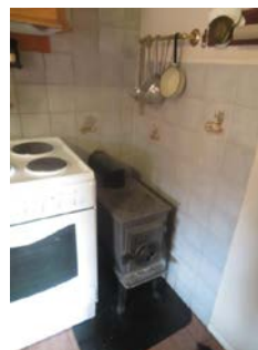
Merk vedovn plassert mellom komfyr og brannmur.
