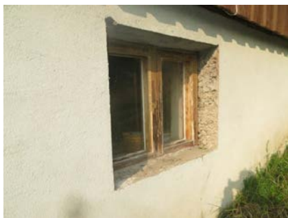
Enklere doble vinduer i kjeller.
