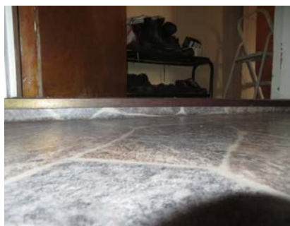
Belegg lagt opp etter terskel som flomsikring.
