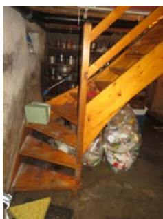
Trapp til kjeller med manglende rekkverk og bernesikringer.
