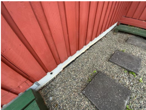
Kontroll av drenering/fuktsikring.
