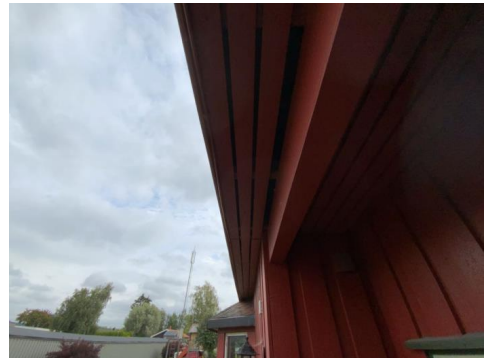
Synlige luftespalter i gesimskasse.
