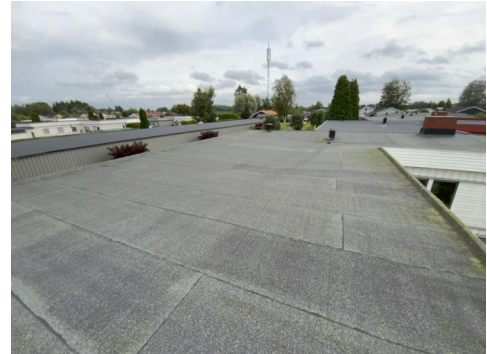
Besiktigelse av taktekke.
