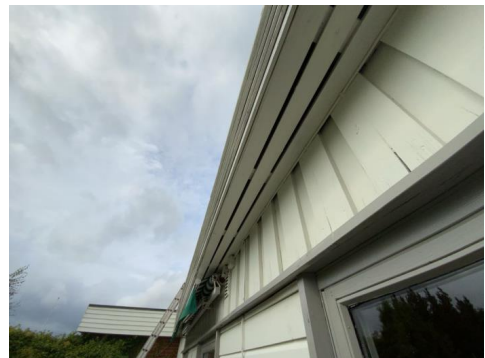
Synlige luftespalter i gesimskasse.
