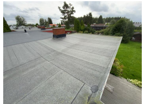
Besiktigelse av taktekke.
