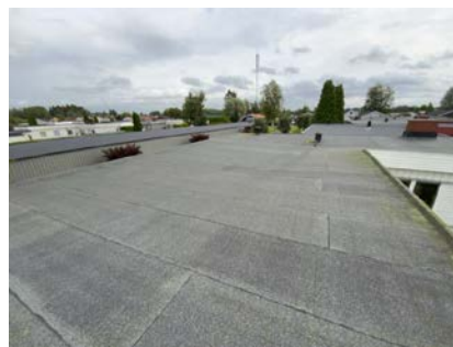
Besiktigelse av taktekke.
