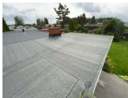
Besiktigelse av taktekke.
