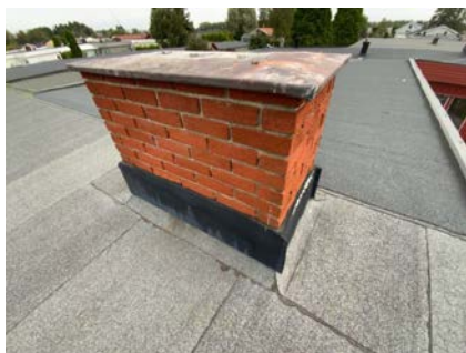
Kontroll rundt pipebeslag.
