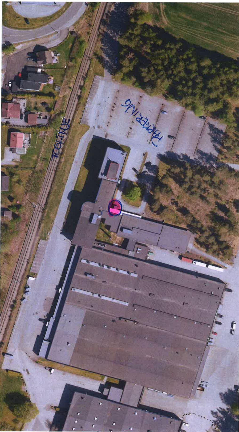
Østfold Næringspark, Vangsveien 10, Askim.
