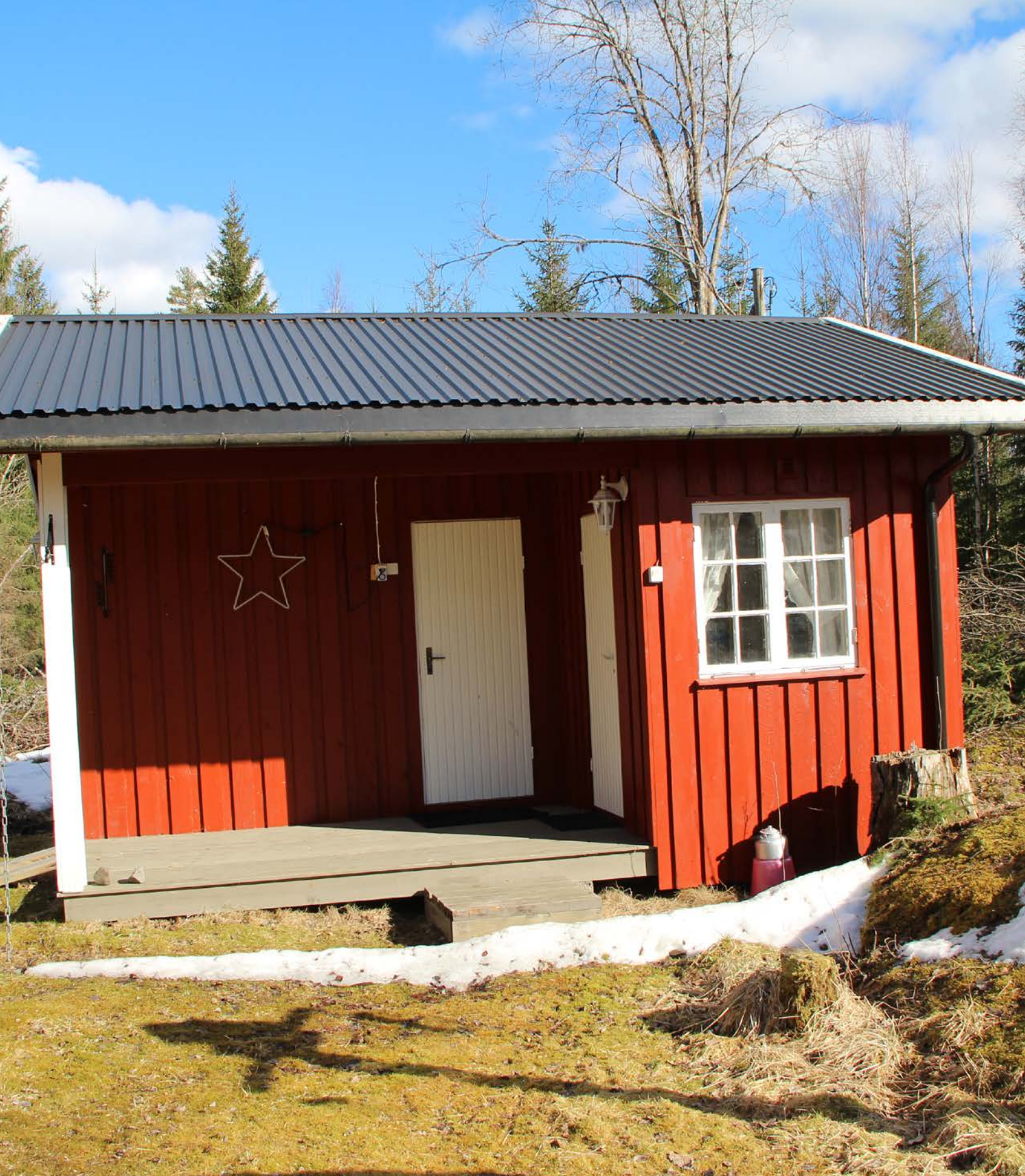
Annekset ble bygget i 2004 og er på 14 m 2 . Det er innlagt strøm via jordkabel til lys og stikkontakt. Selgers bilde.
