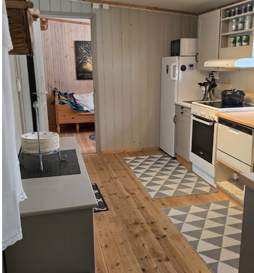
Det er montert kjøkkenventilator med avtrekk direkte ut. Selgers bilde.
