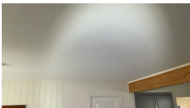
Ufagmessig montering av himlingsplater.
