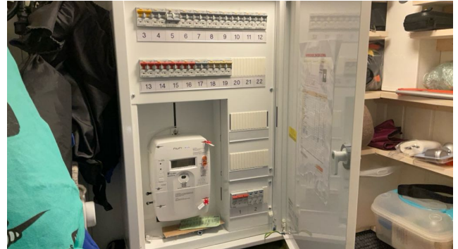
Automatisk sikringsskap.
