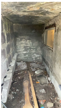
Deler av grunnmur mot vest av naturstein.
