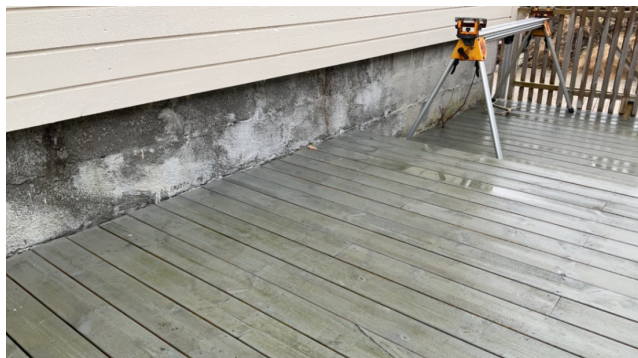
Grunnmur av lettklinkerstein mot nord.
