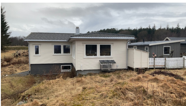
Nye vinduer uten ventiler.
