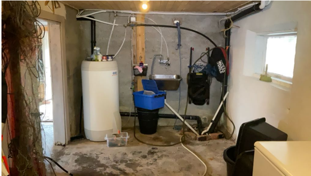
Avløpsrør i kjeller.
