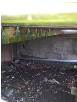
Bilde av tilbygget grunnmur av lettlinkerstein under inngangs terrasse.
