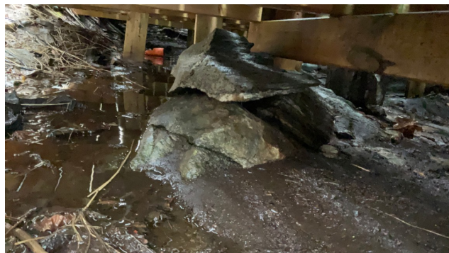
Grøft for vannavrenning under terrasse mot vest.
