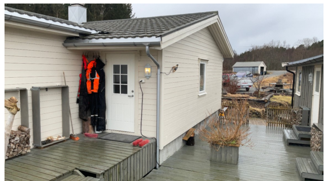
Tilbygd inngangsparti med krypekjeller mot nord. Ingen tilgang for inspeksjon.
