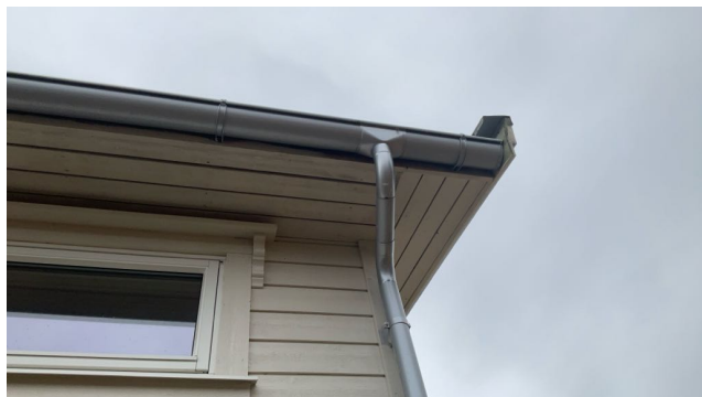
Takrenner og nedløp av metall.
