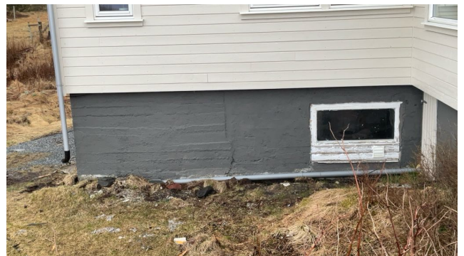
Grunnmur mot øst av støpt betong.
