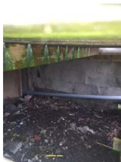
Bilde av tilbygget grunnmur av lettklinkerstein under inngangs terrasse.
