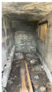
Deler av grunnmur mot vest av naturstein.
