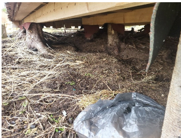
Fundamentering av kappede trær på flere av tillegggs hus på gården.
