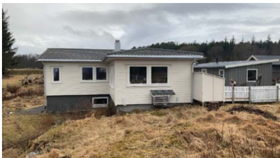
Nye vinduer uten ventiler.
