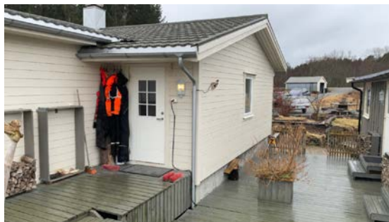
Tilbygd inngangsparti med krypekjeller mot nord. Ingen tilgang for inspeksjon.
