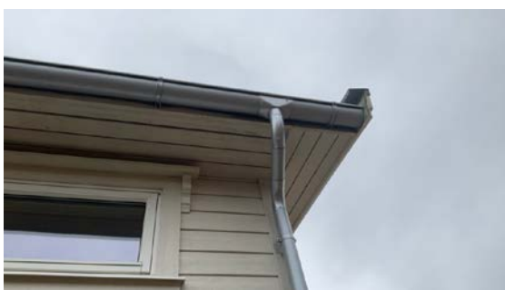
Takrenner og nedløp av metall.
