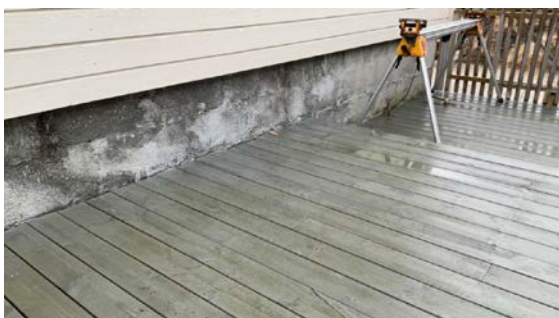
Grunnmur av lettklinkerstein mot nord.
