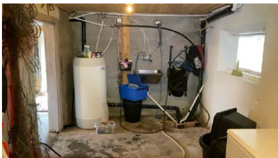
Avløpsrør i kjeller.
