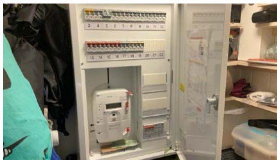
Automatisk sikringsskap.
