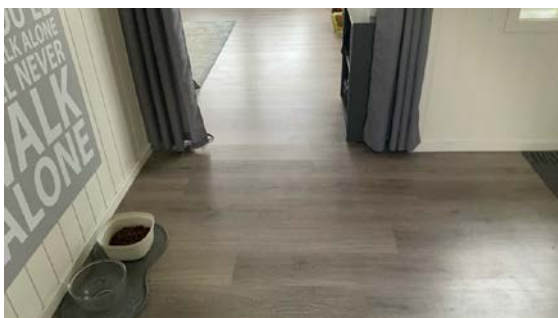
Kul i gulv i overgang til stue.
