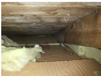
Ingen luftig ut over raft.
