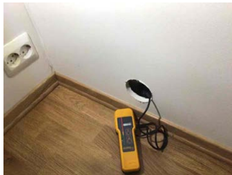
Hulltaking i soverom bak dusj
