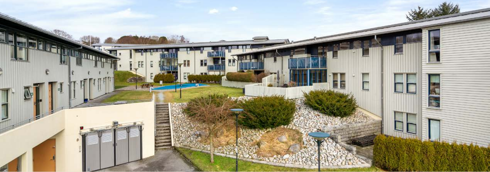
Innkjørsel til garasjeparkering.
