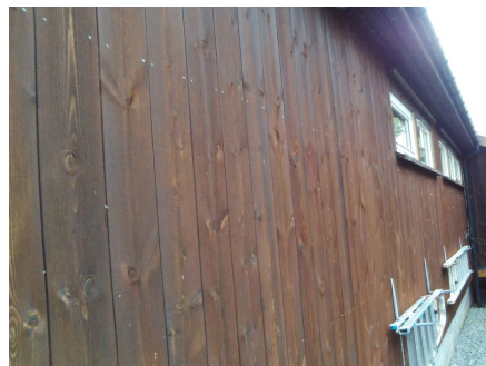
Deler av ene fasaden
