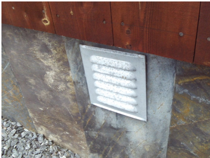
Bra med ventiler i ringmur.
