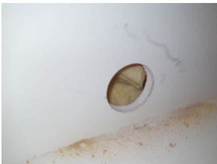
Hulltaking i fra hjørneskap på kjøkken.
