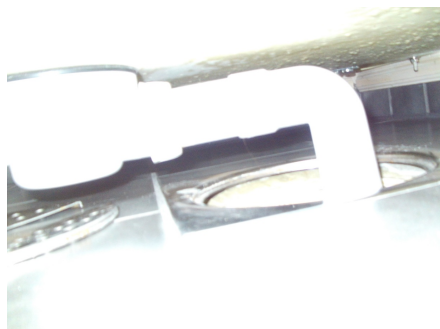
Sluk under dusjkabinett.
