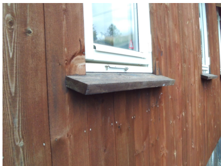
Deler av kledningen med tilhørende belistninger
