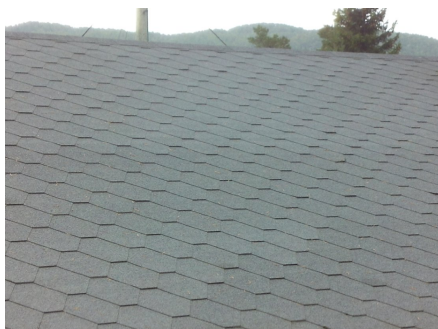
Deler av taktekkingen.
