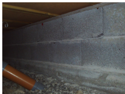
Bæremur under midten av hytta
