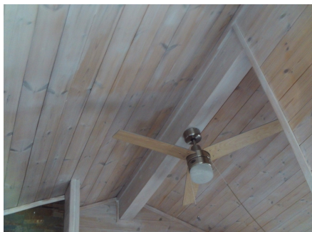
Takkonstruksjonen er en lukket konstruksjon.
