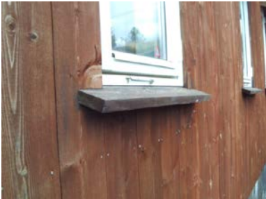
Deler av kledningen med tilhørende belistninger
