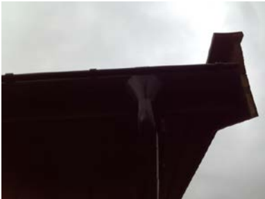
Takrenner av stål på ene siden av hytta.
