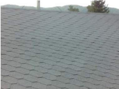
Deler av taktekkingen.
