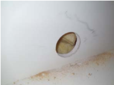
Hulltaking i fra hjørneskap på kjøkken.
