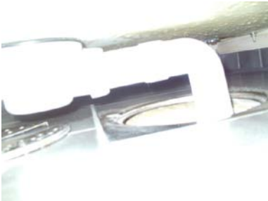
Sluk under dusjkabinett.
