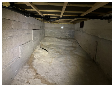
Krypkjeller under tilbygg.
