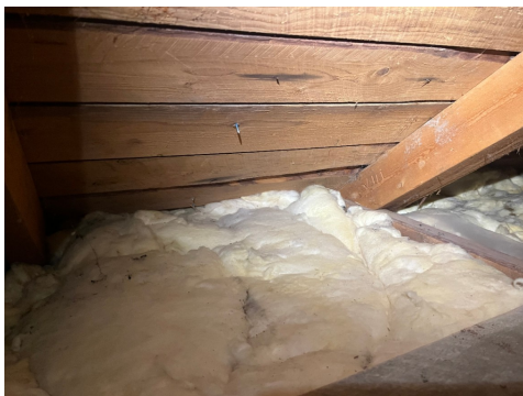
Det må lages luftespalte mellom isolasjon og undertak
