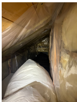
Det må lages luftespalte mellom isolasjon og undertak
