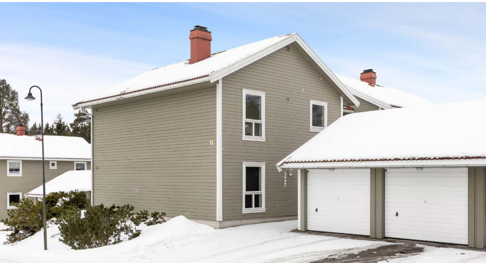
Til leiligheten medfølger garasje i felles rekke - denne har et areal på ca. 18 kvm.
