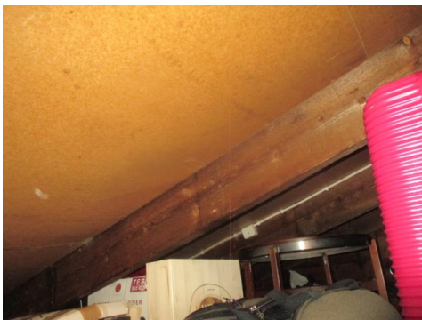
Sutakplater som undertak.
