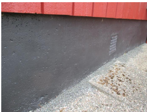
Deler av støpt ringmur.
