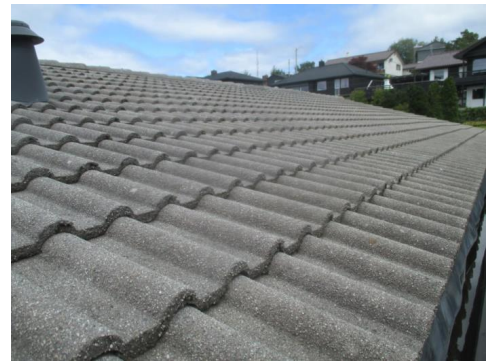
Sett i fra takfoten i stige.
