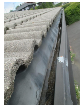
Deler av takrenner bak pannebord.
