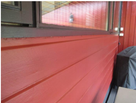
Deler av kledningen med tilhørende belistninger.
