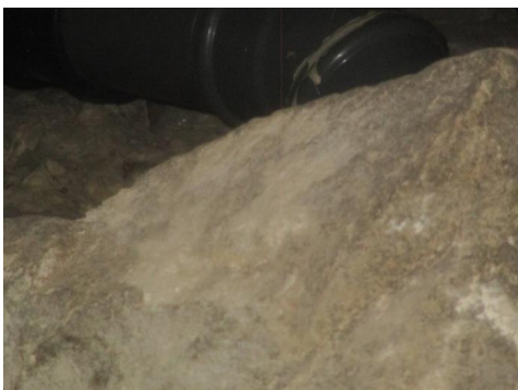
En del fjell og sprengte masser.
