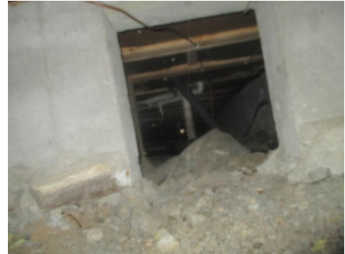
Deler av krypkjeller
