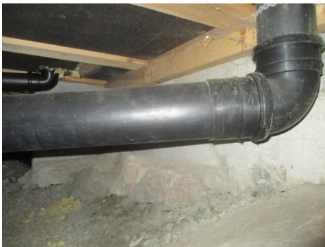
Synlige avløpsrør i krypkjeller.
