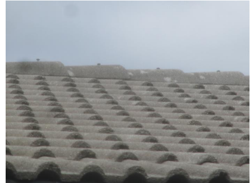
Deler av taktekkingen.
