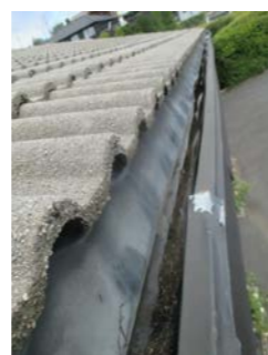
Deler av takrenner bak pannebord.
