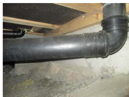
Synlige avløpsrør i krypkjeller.
