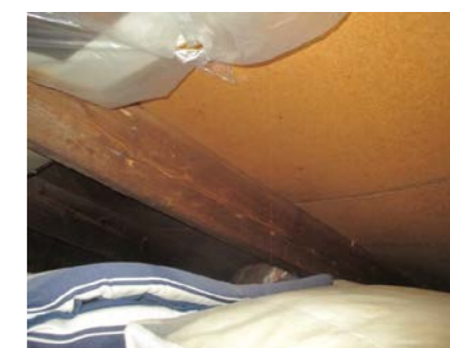
Deler av kaldloftet over tidligere carport.
