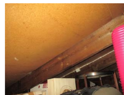
Sutakplater som undertak.
