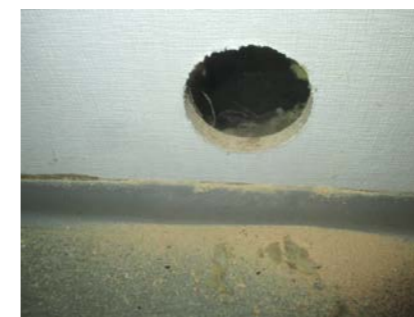
Hulltaking i vegg i mot bad.
