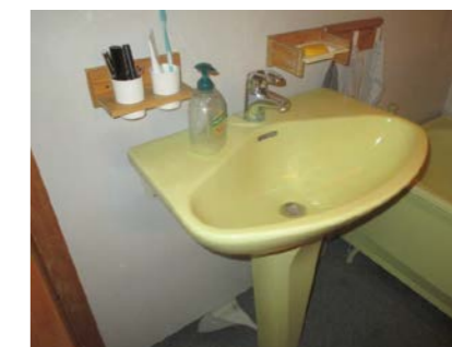
Eldre opprinnelig vvs utstyr.
