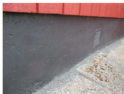
Deler av støpt ringmur.
