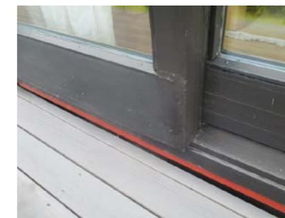
Noe slitt utvendig.
