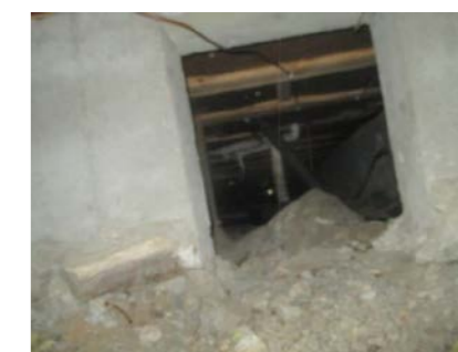
Deler av krypkjeller
