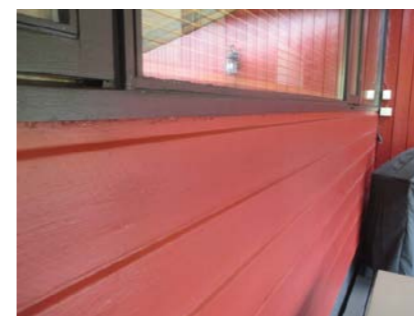
Deler av kledningen med tilhørende belistninger.
