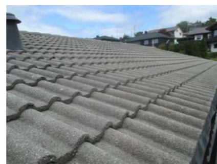
Sett i fra takfoten i stige.
