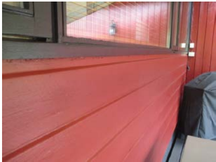
Deler av kledningen med tilhørende belistninger.
