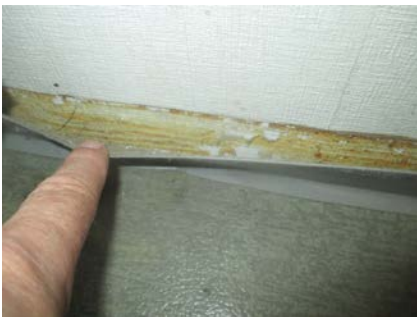
Plastlist i overgang gulv og vegg har løsnet.
