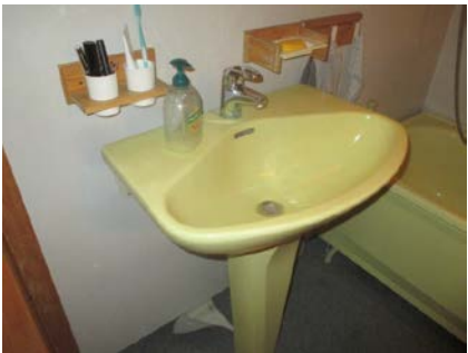
Eldre opprinnelig vvs utstyr.
