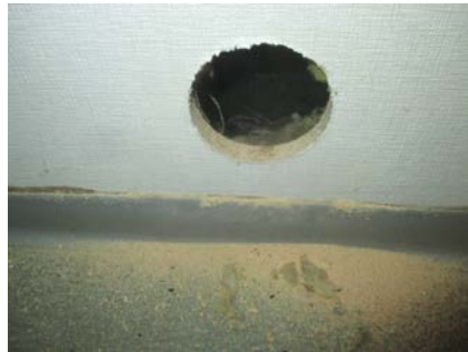
Hulltaking i vegg i mot bad.
