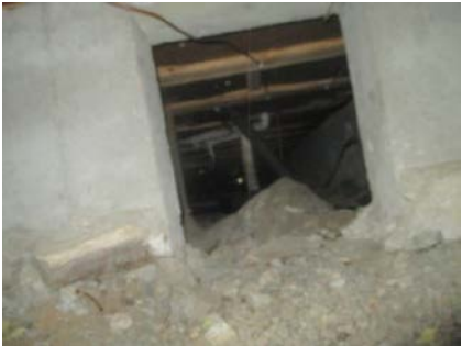
Deler av krypkjeller
