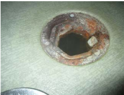
Eldre opprinnelig sluk.
