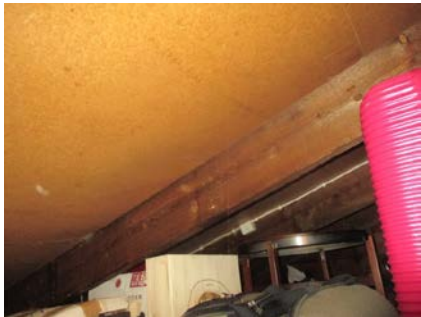
Sutakplater som undertak.
