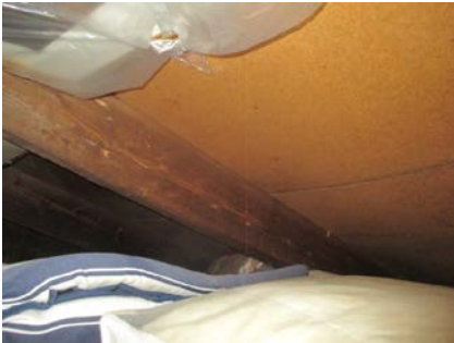
Deler av kaldtloftet over tidligere carport.
