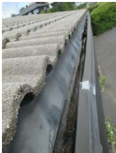
Deler av takrenner bak pannebord.
