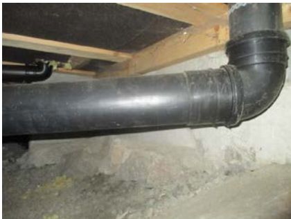
Synlige avløpsrør i krypkjeller.
