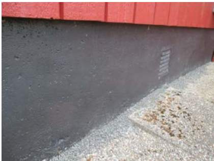
Deler av støpt ringmur.
