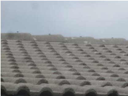
Deler av taktekkingen.
