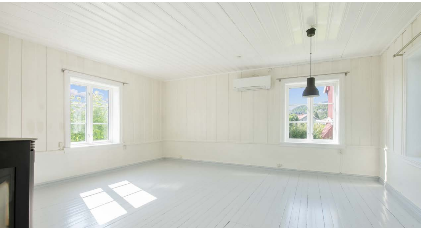
I stuen er en luft til luft varmepumpe fra 2018.
