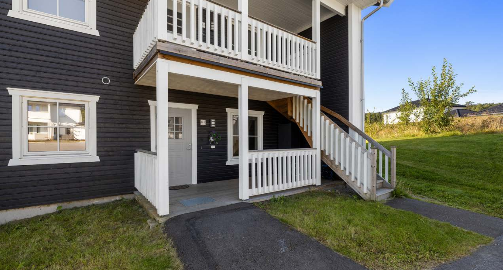
Overbygget inngangsparti med plass til kafesett.
