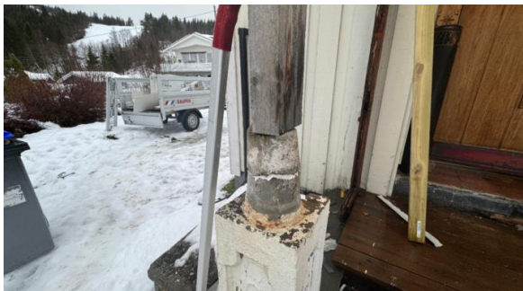
Provisorisk søyle på takopplett.
