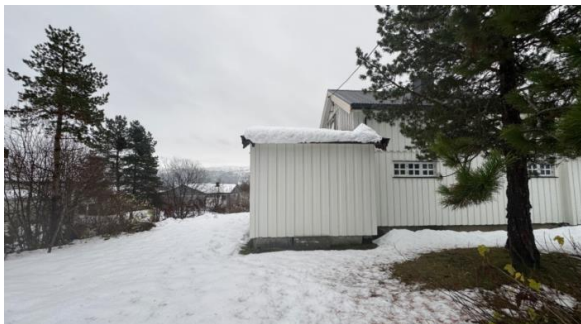
Tak på tilbygg var ved befarings dekket av snø.
