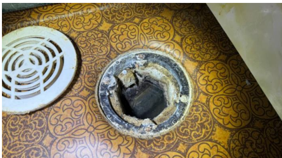
Kontroll av sluk.
