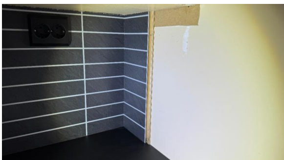
Ufagmessig avslutning av kjøkkenplater.
