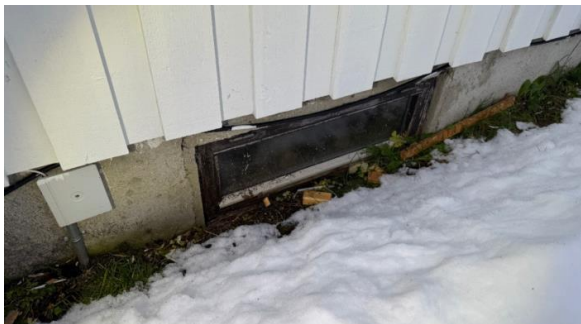
Vindu er delvis under planert terreng.
