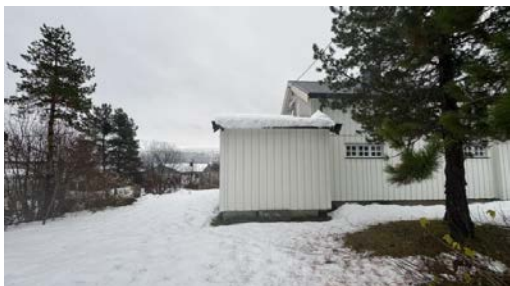
Tak på tilbygg var ved befaring dekket av snø.
