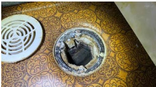
Kontroll av sluk.
