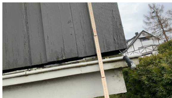
Rekkverk for lavt
