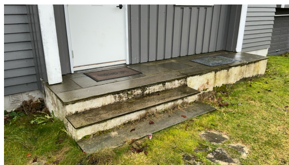
Mangler rekkverk
