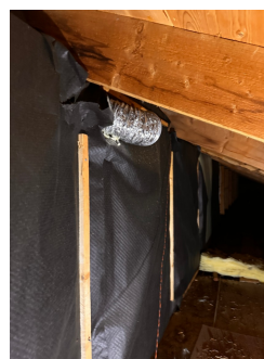
Fuktighet registrert i undertak ved pipe.
