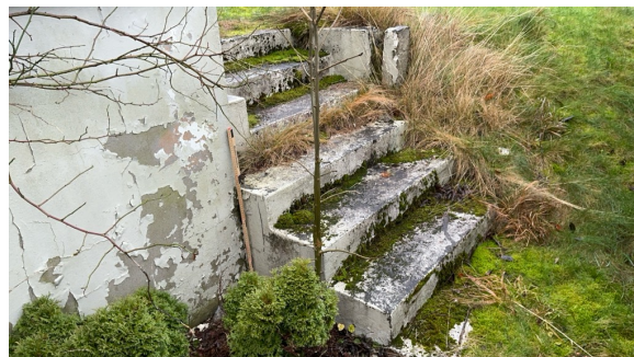
Mangler rekkverk
