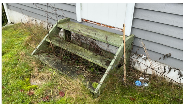
Mangler rekkverk
