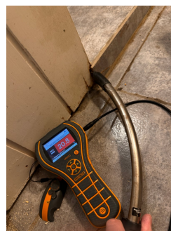
Fuktslag ved måling på vegg i gang ved åpning til dusj/våtrom
