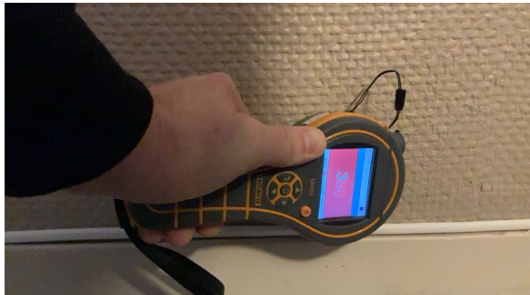
Fuktutslag i vegg på soverom
