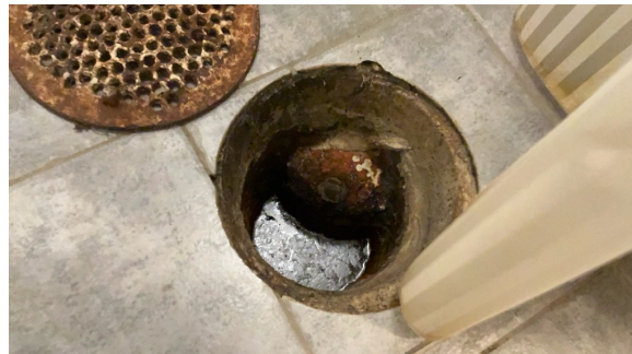
Ingen membran funnet i sluk
