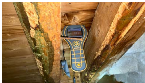
Fuktighet registrert i undertak ved pipe.
