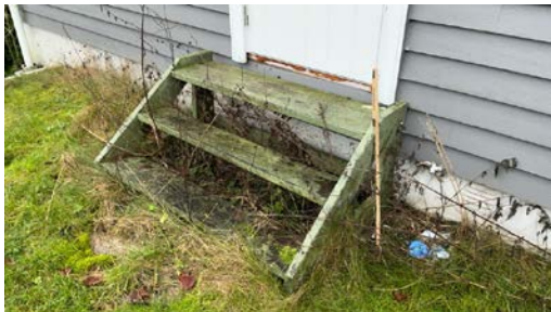
Mangler rekkverk
