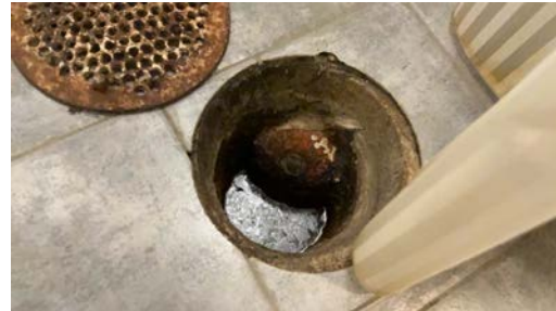
Ingen membran funnet i sluk
