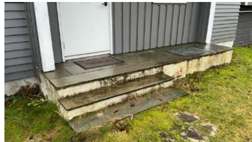
Mangler rekkverk
