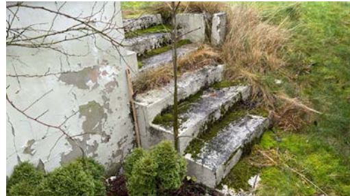
Mangler rekkverk
