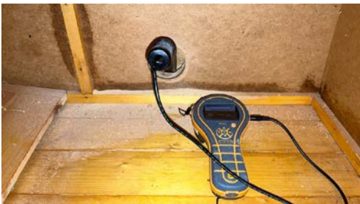
Ingen fuktutslag registrert ved fuktmåling i vegg
