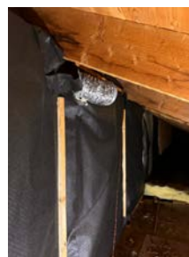
Fuktighet registrert i undertak ved pipe.
