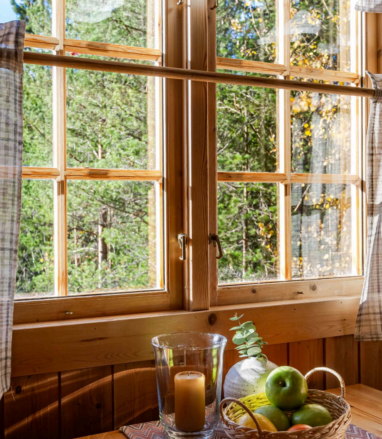
To-lags koplede vinduer med utvendige faste sprosser.
