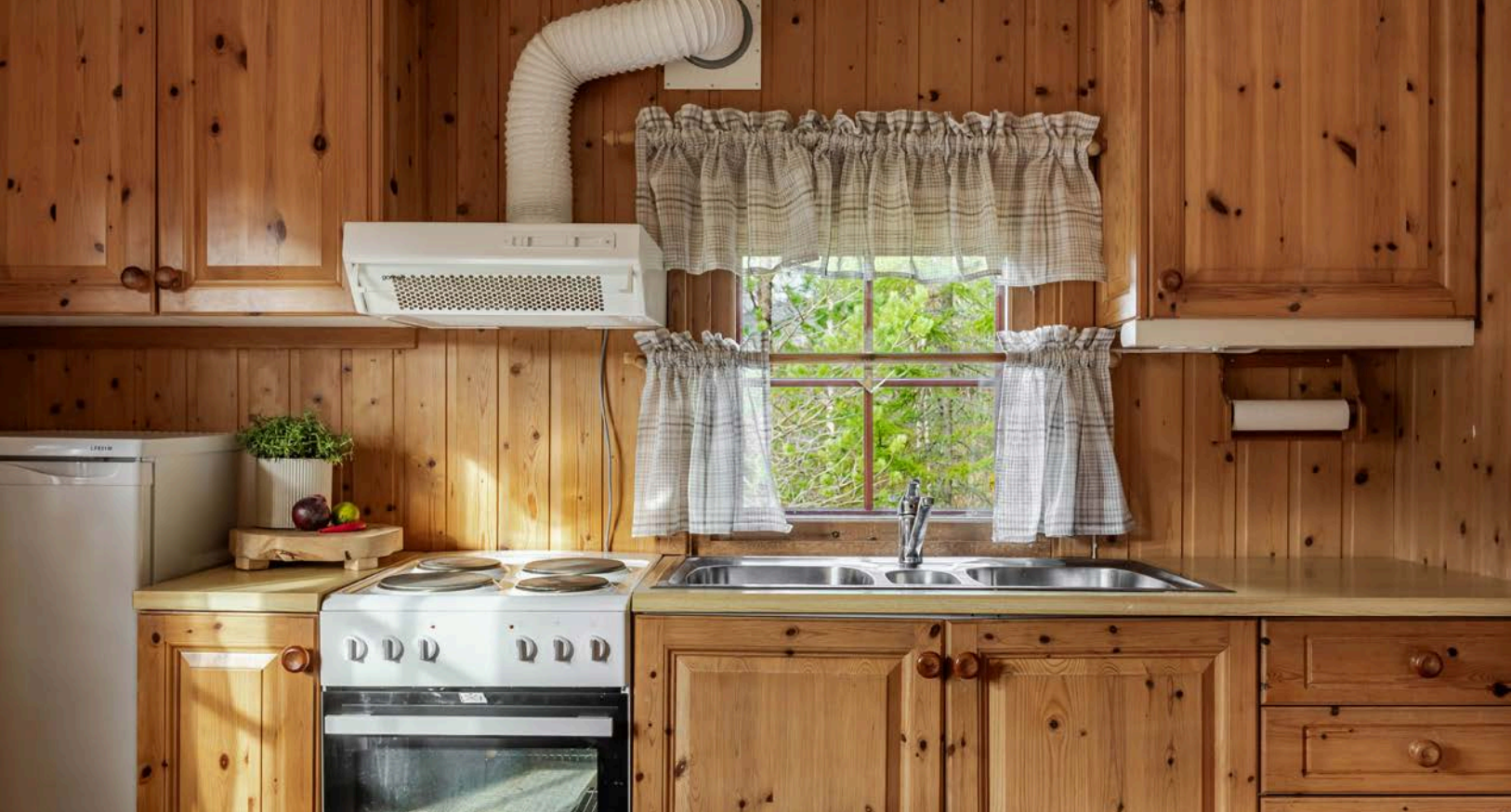
Tidstypisk hyttekjøkken i normal tilstand etter alder. Innredningen har profilerte fronter og laminert benkeplate med nedfelt kum. Hytta har ikke innlagt vann eller avløp, men det er provisorisk opplegg for sommervann.
