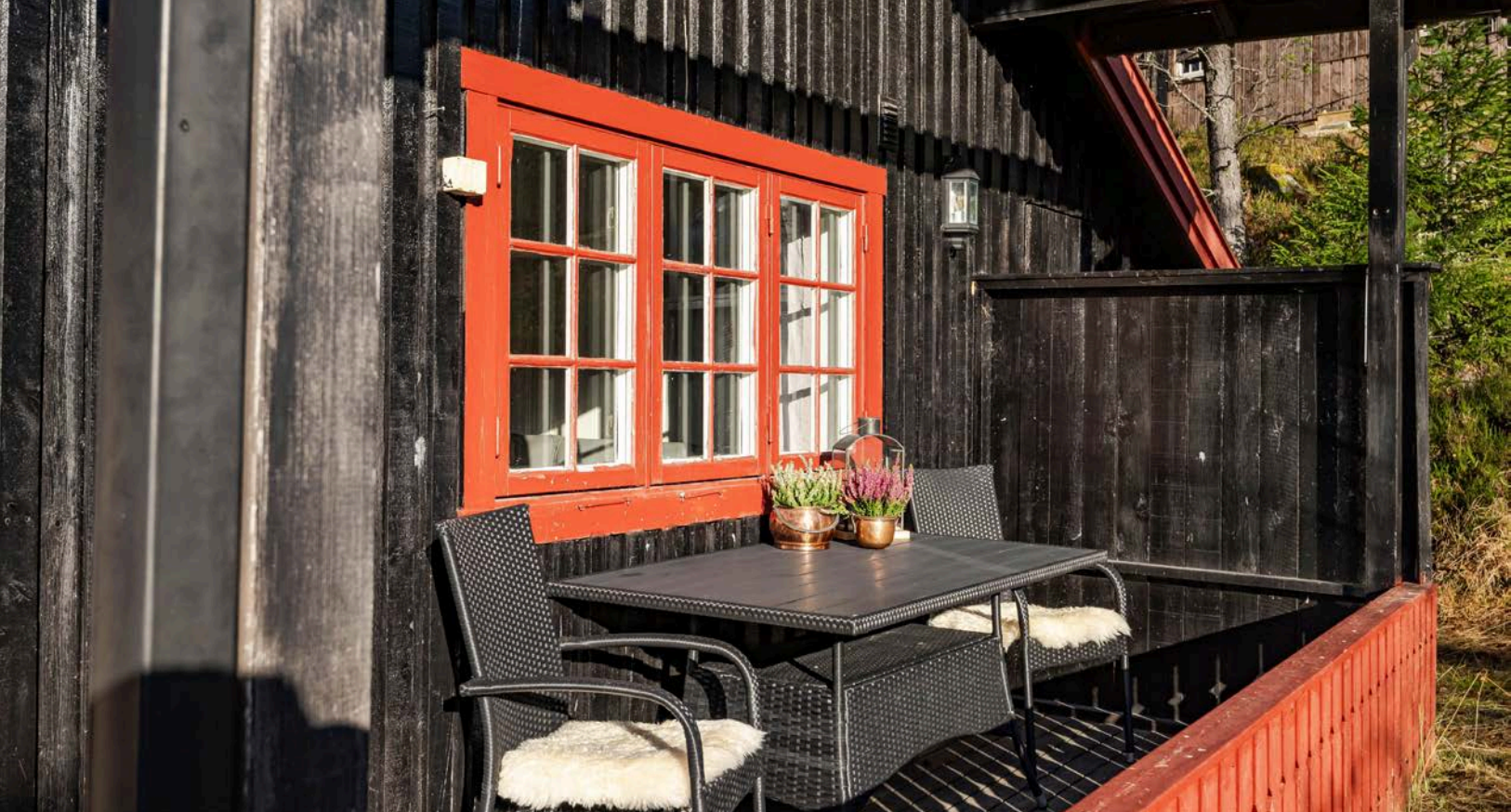
Overbygget terrasse mot syd med gode solforhold. Det er montert utebelysning og utvendig stikkontakt.
