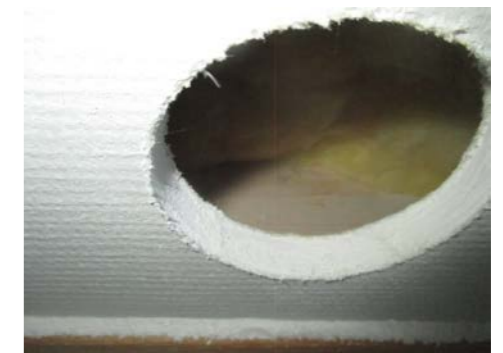
Hulltaking i mot dusjhjørne
