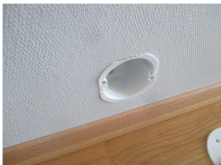
Hulltaking i mot dusjhjørne.
