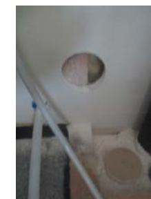
Hulltaking i fra skap ved bereder.
