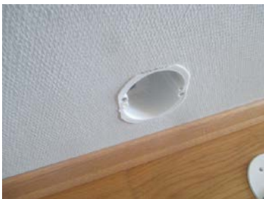
Hulltaking i mot dusjhjørne.
