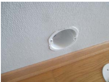
Hulltaking i mot dusjhjørne.
