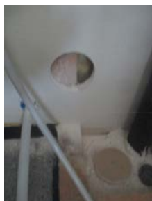
Hulltaking i fra skap ved bereder.
