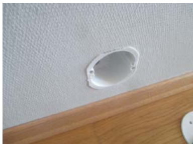
Hulltaking i mot dusjhjørne.
