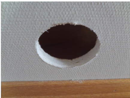
Hulltaking i fra gangen.
