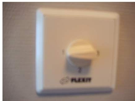
Styring av nlegget i gangen.
