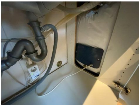
Besiktigelse av bereder.
