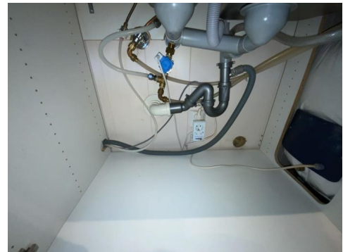
Besiktigelse av røropplegg.
