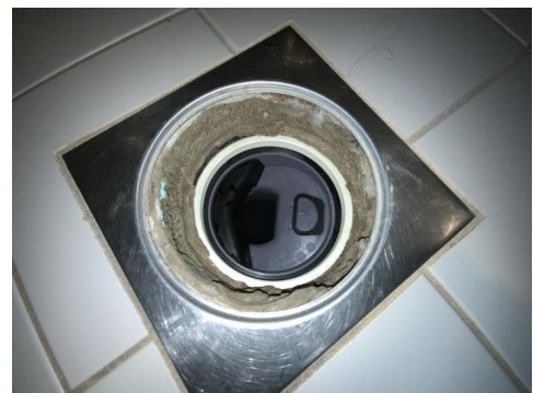
Kontroll av sluk.
