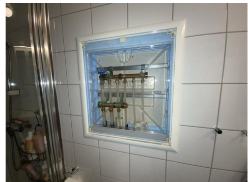
Besiktigelse av røropplegg.
