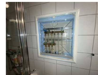
Besiktigelse av røropplegg.
