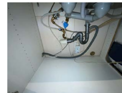
Besiktigelse av røropplegg.
