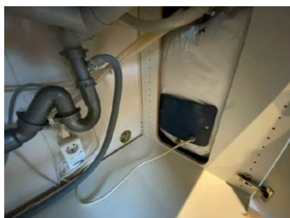
Besiktigelse av bereder.
