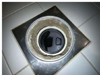
Kontroll av sluk.
