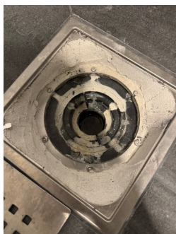
Bilde av sluk i gulv på vaskerom.
