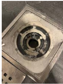
Bilde av sluk i gulv på vaskerom.
