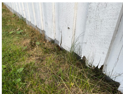
Råteskadet kledning.
