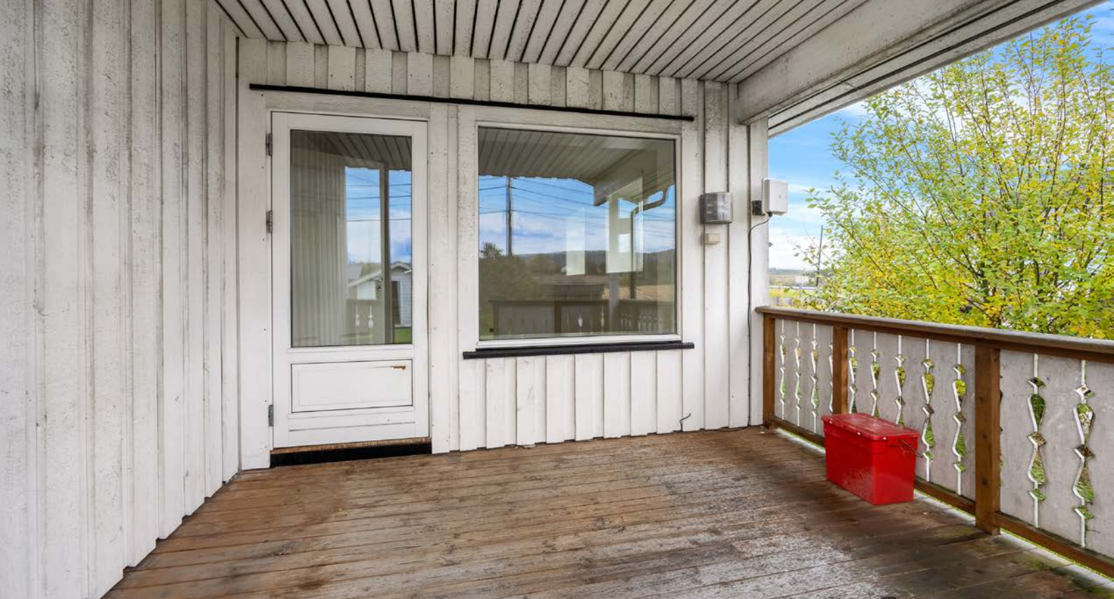
Boligen har tilgang til en overbygget terrasse på ca. 11 kvm.
