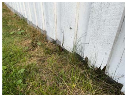
Råteskadet kledning.
