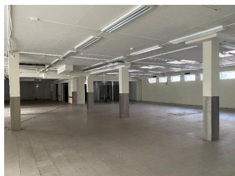
Bæresystem av betong
