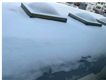
Sarnafiltekke med overlyskupler.
