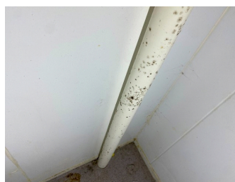
Svertesopp i kjølerom i varemottak
