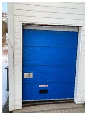
Skade på portomramming
