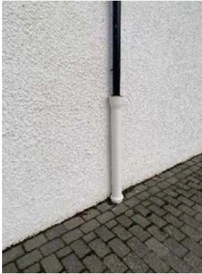
Opprinnelig soilrør som kommer opp fra bakken
