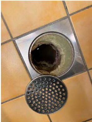
Eldre sluk på bad
