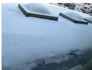
Sarnafiltekke med overlyskupler.
