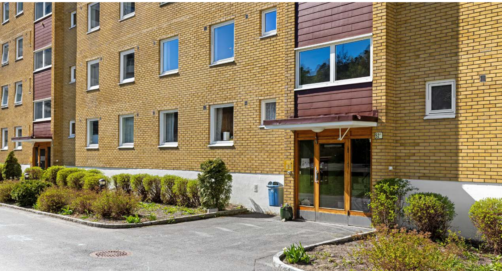
Inngangsparti i Låveveien 52C.
