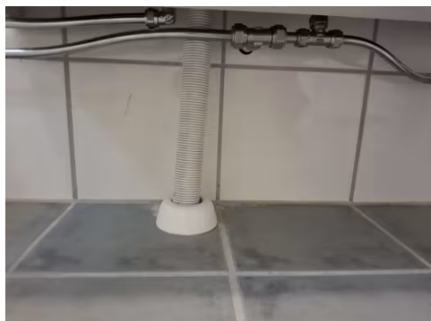
Synlige avløpsrør av plast og støpejern.
