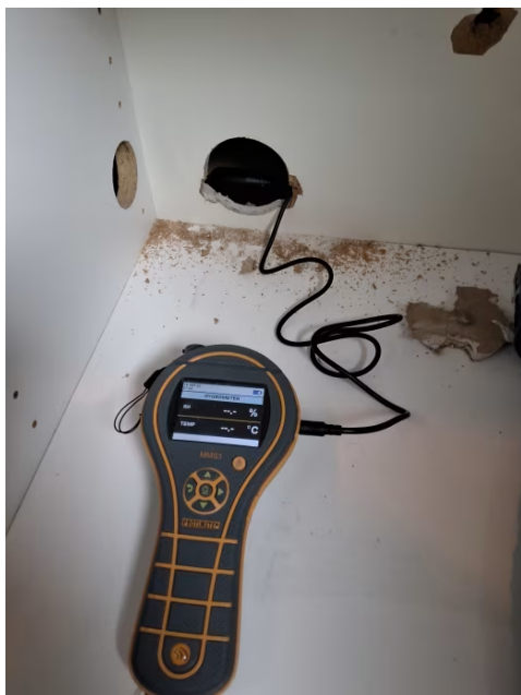
Bilde fra fuktmåling i veggkonstruksjon tilstøtende bad.
