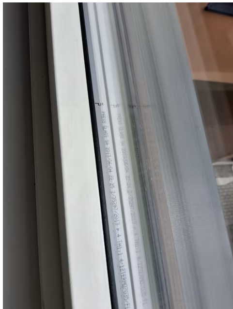
Leiligheten har vinduer med tre-lags glass.
